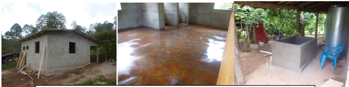
Apoyo al Grupo Indígena Tolupan de mujeres Manos del Mañana, en la construcción de local para la fabricación de comercialización de artesanías de acícula de pino, y mejoramiento de condiciones de salubridad en vivienda de socias, en este caso pila para agua de uso domestico.
